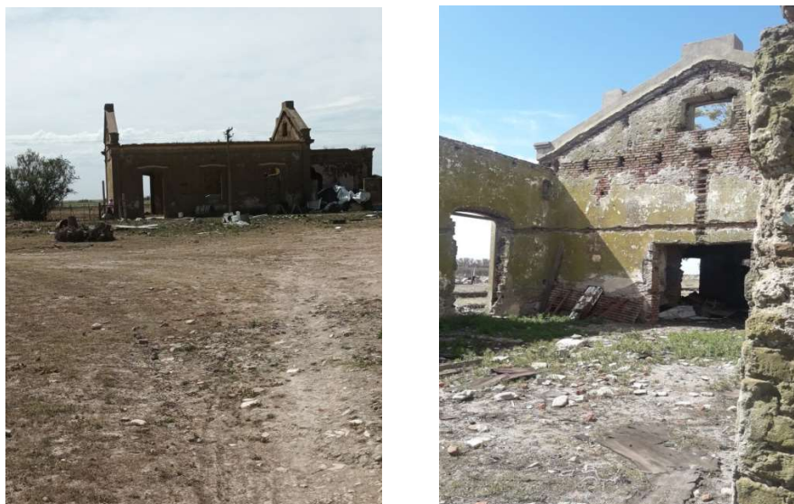
Fotografía 4 Destrucción de la estación Bajo Hondo
