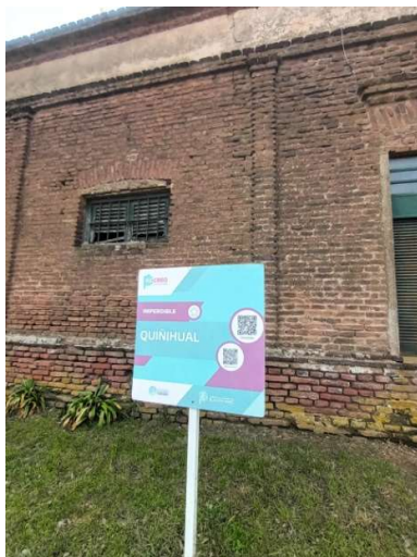
Fotografía 10: Exterior e interior del almacén / pulpería
