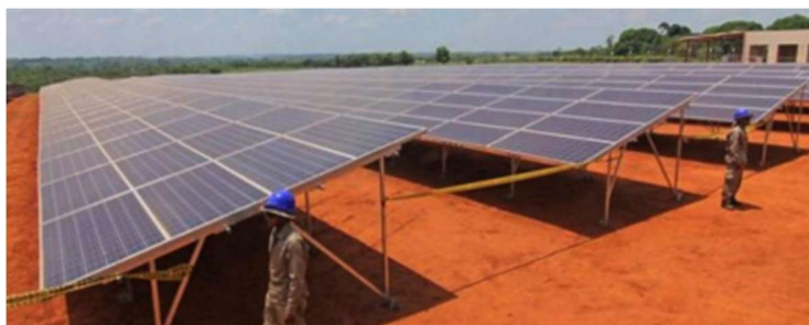
Ilustración 19 - Imagen de un Panel Fotovoltaico (Lic. Vera, 2018)
